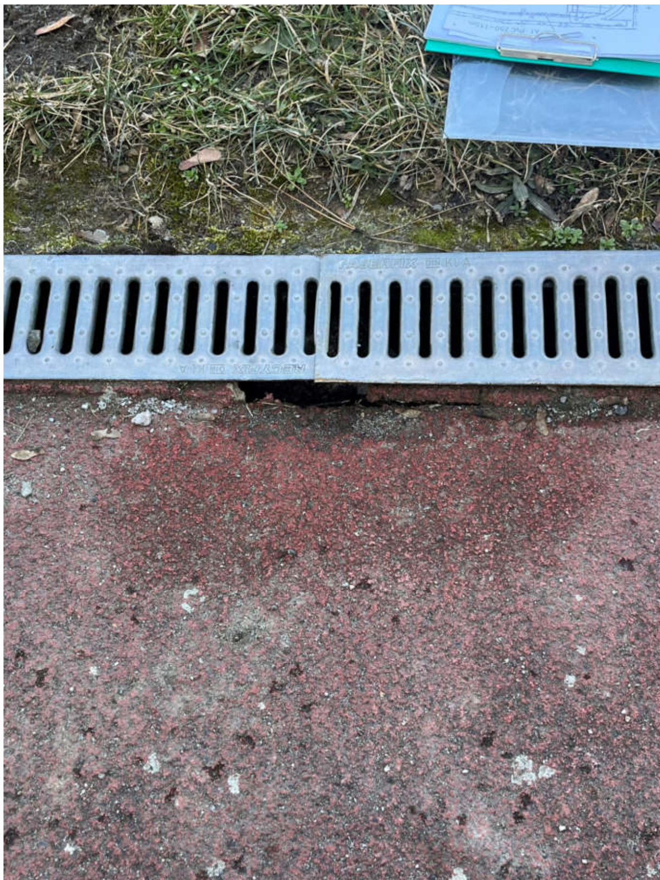
propadlá místa u odvodňovacího žlábků
