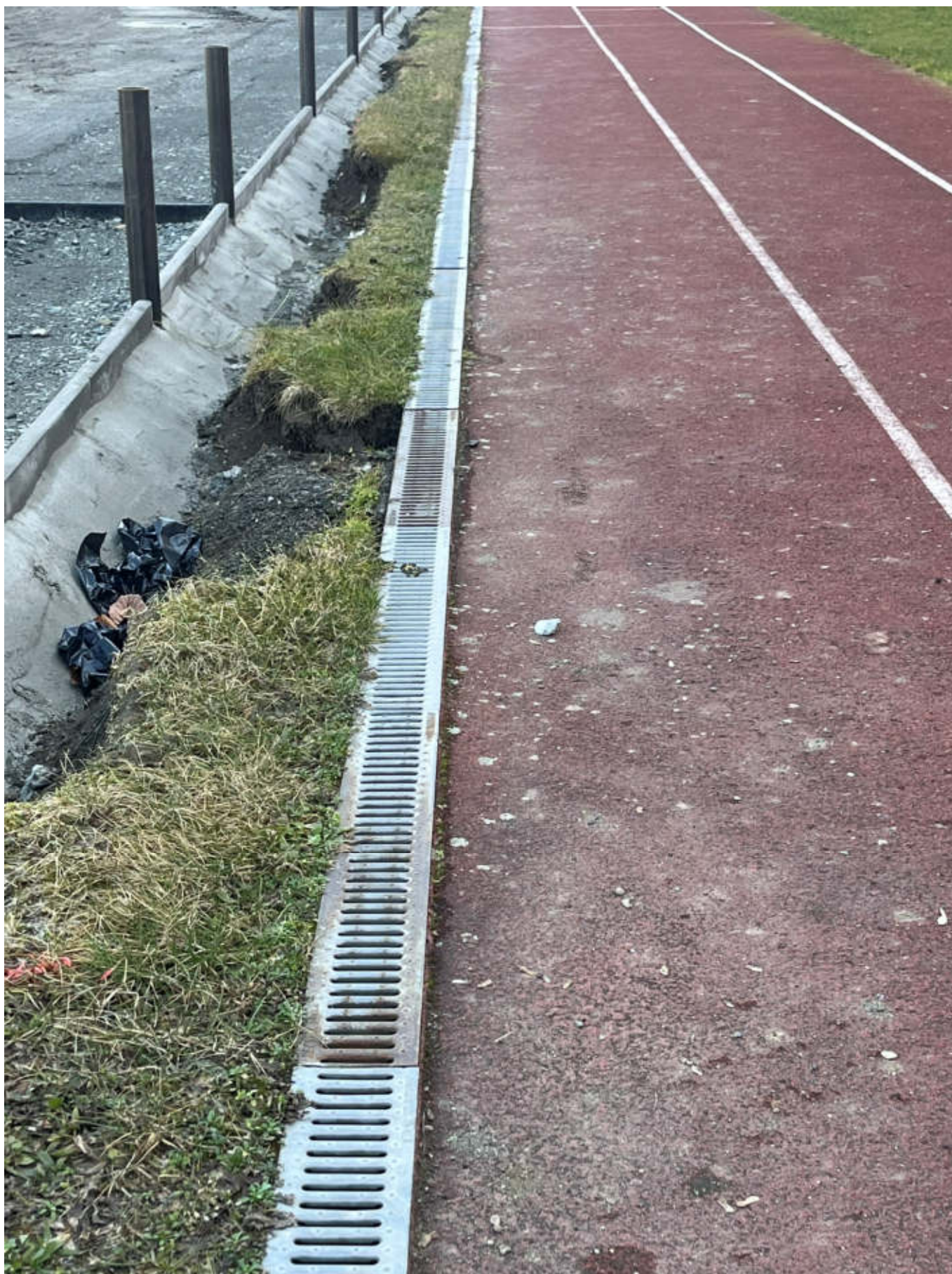
propadlá místa u odvodňovacího žlábků, žlábek je výškově nad odvodňovanou plochou dráhy
