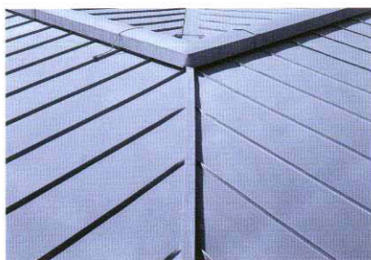
Nároží s lištou a krycím profilem
