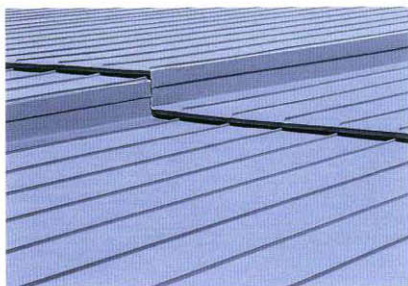
Příčný spoj jako spádový stupeň
