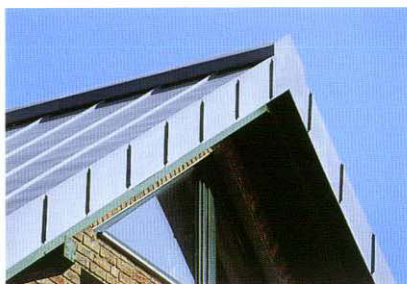
Standardní provedení hřebene sedlové střechy s odvětráním
