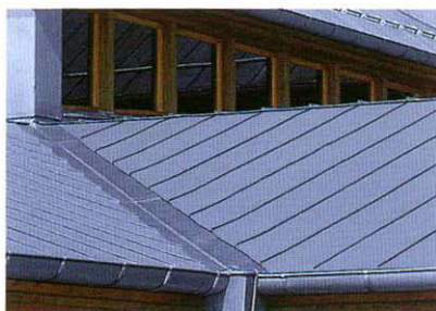
Úžlabí s jednoduchou ležatou drážkou a s přidavnou drážkou
