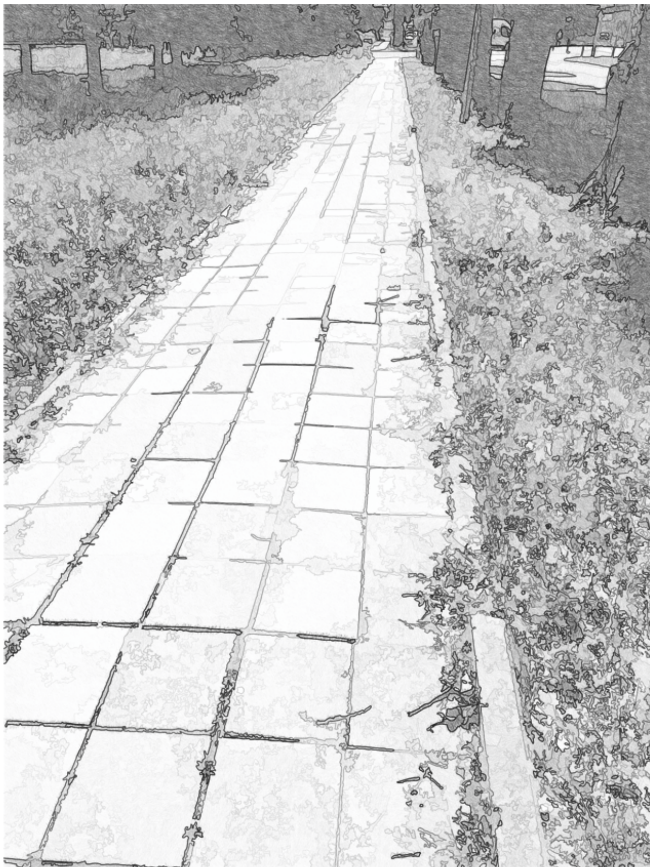
Oprava chodníku tř. T. Bati, Otrokovice - Baťov parc. č. 438/333 a 438/332, k.ú. Otrokovice
