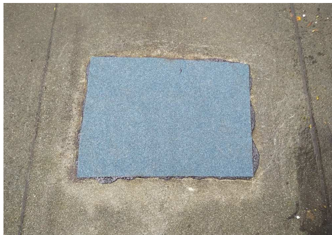
foto/10/ Pohled na zapravenou sondu S3
