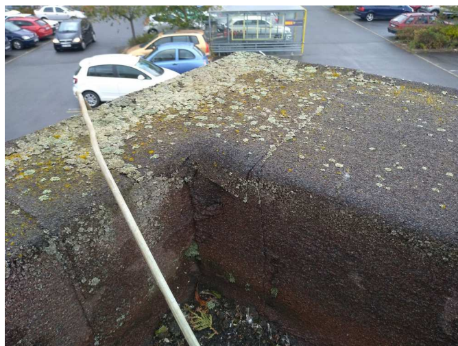
foto/20/ Pohled na nečistoty v rohu atiky horní střechy
