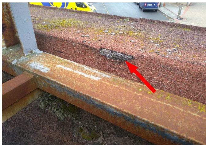
foto/31/ Pohled na poškozenou hlavní hydroizolační vrstvu
