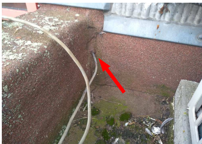
foto/27/ Pohled na prostup bleskosvodu hlavní hydroizolační vrstvou
