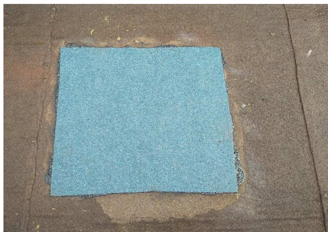
foto/8/ Pohled na zapravenou sondu S2
