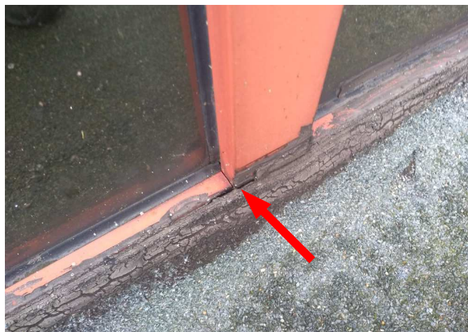
foto/44/ Pohled na netěsnost v místě napojení hydroizolace na okenním rám
