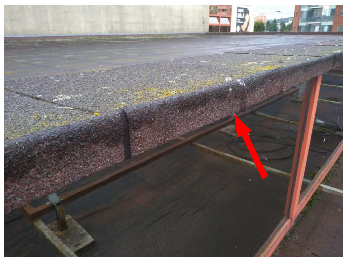
foto/38/ Pohled na ukončení asfaltových pásů na závětrné liště
