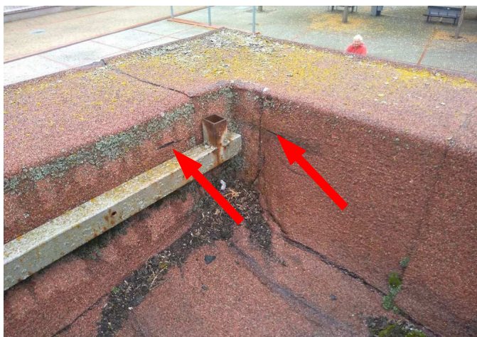
foto/32/ Pohled na poškozenou hlavní hydroizolační vrstvu
