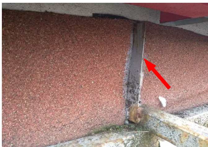
foto/33/ Pohled na výšku vytažení hlavní hydroizolace a mechanické ukotvení kovové konstrukce obchodního poutače
