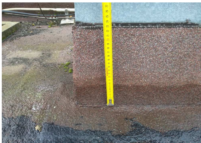
foto/23/ Pohled na výšku vytažení hlavní hydroizolace na větrací potrubí VZT
