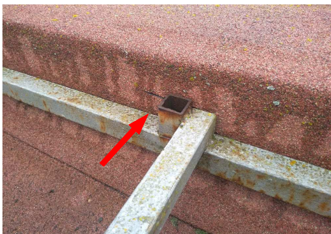
foto/34/ Pohled na poškozenou hlavní hydroizolační vrstvu
