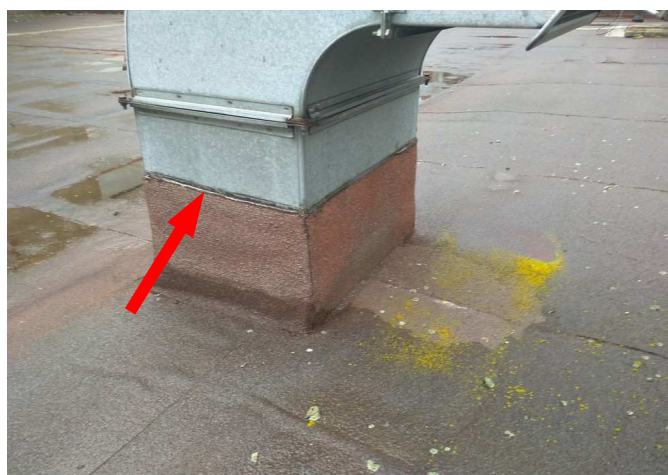
foto/22/ Pohled na opravování větracího potrubí VZT
