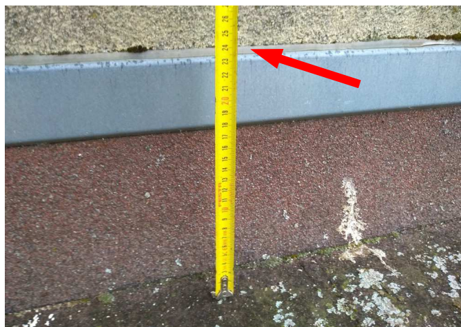
foto/40/ Pohled na vytažení a ukončení hlavní hydroizolační vrstvy na obvodové stěně
