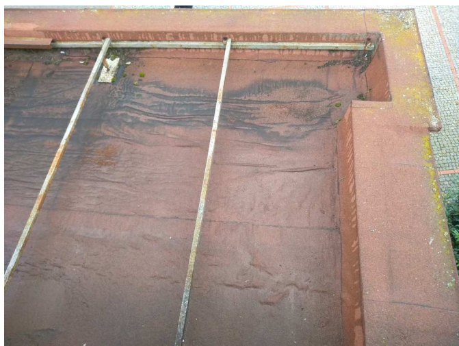
foto/19/ Pohled na zvlněnou hydroizolaci spodní střechy
