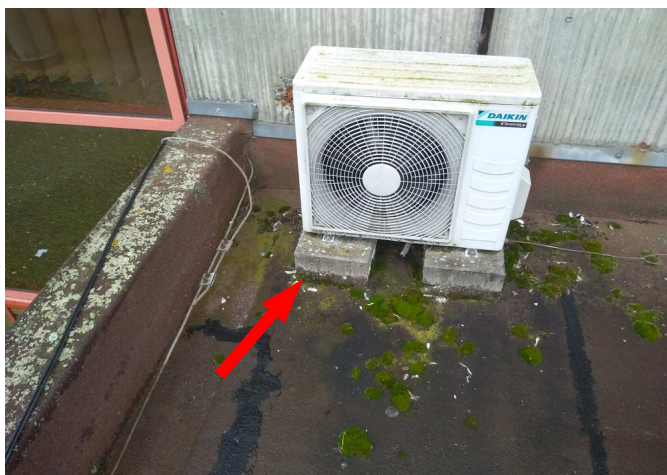
foto/24/ Pohled na uložení klimatizační jednotky a množství nečistot a usazenin (náletová zeleň, mechy a lišejníky)
