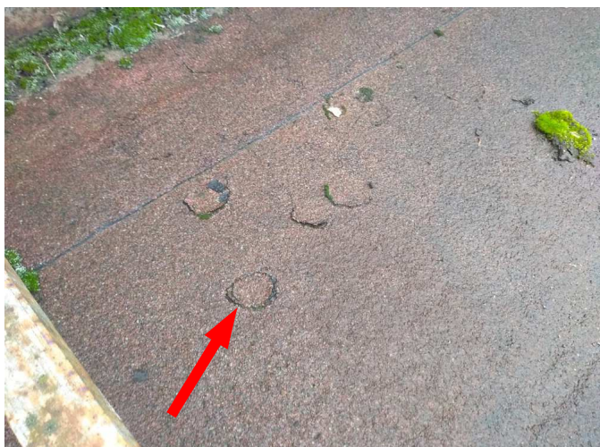
foto/14/ Pohled na poškozenou hydroizolaci na spodní střeše
