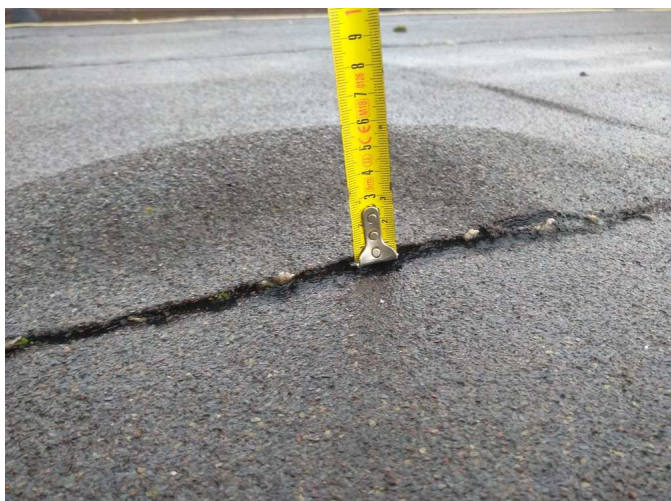
foto/16/ Pohled na boule na horní střeše
