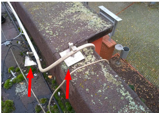
foto/26/ Pohled na elektrické vedení a kovové podpěry, které jsou v přímém kontaktu s hydroizolační vrstvou
