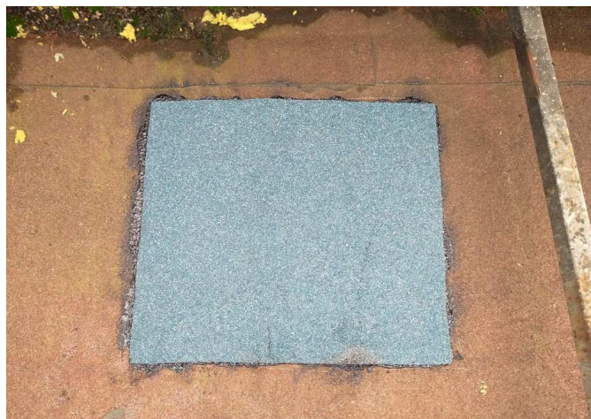
foto/6/ Pohled na zapravenou sondu S1
