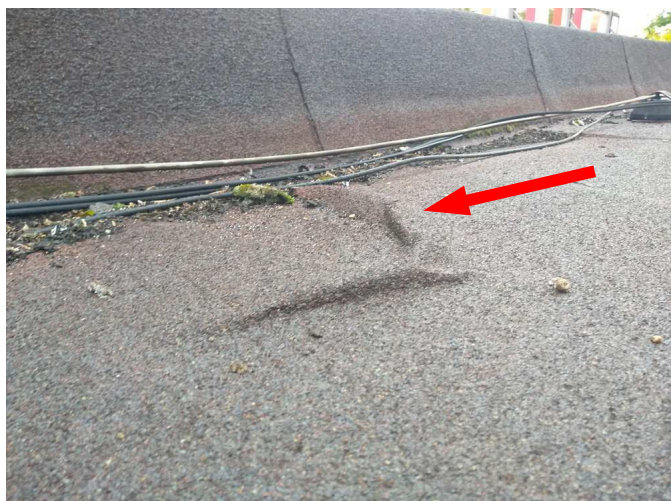
foto/15/ Pohled na zvlněnou hydroizolaci horní střechy
