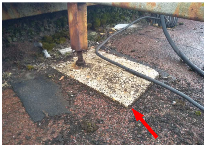
foto/29/ Pohled na uložení konstrukce obchodního poutače
