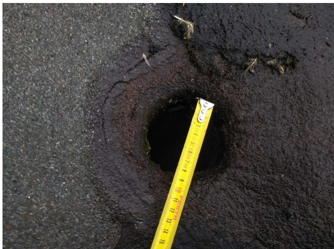
foto/48/ Pohled na rozměr střešního vtoku
