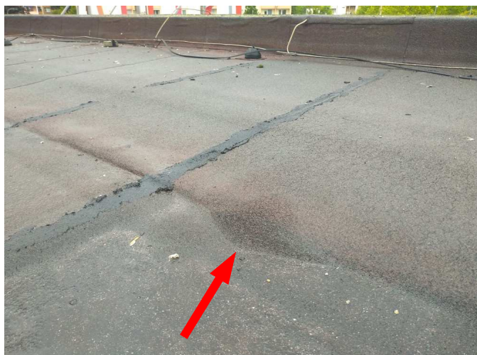
foto/13/ Pohled na boule na horní střeše
