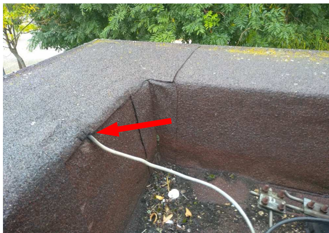
foto/25/ Pohled na prostup bleskosvodu hlavní hydroizolační vrstvou
