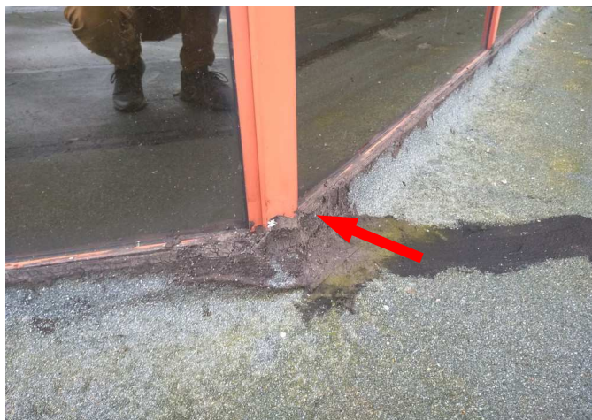
foto/43/ Pohled na ukončení hydroizolace na okenním rámu
