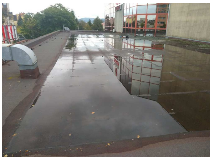
foto/17/ Pohled na místa se zadržanou vodou, které se vyznačovaly nulovým spádem
