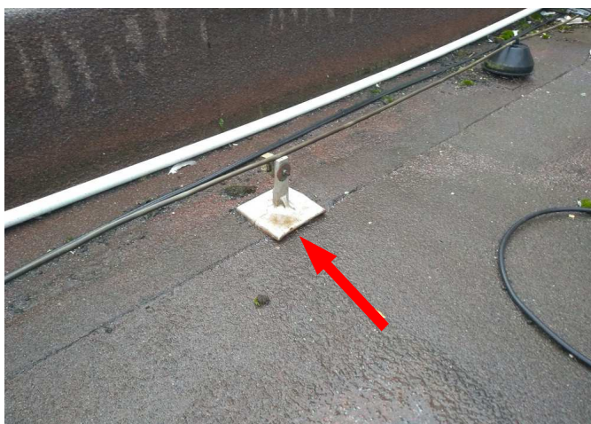
foto/28/ Pohled na vedení bleskosvodu a kovové podpěry, které jsou v přímém kontaktu s hydroizolační vrstvou
