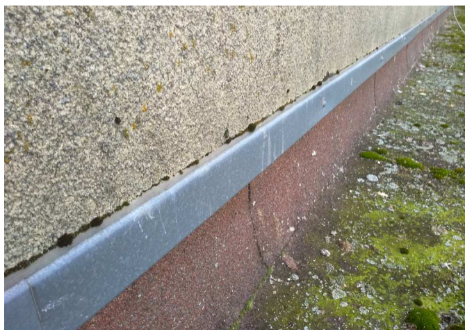
foto/39/ Pohled na vytažení a ukončení hlavní hydroizolační vrstvy na obvodové stěně
