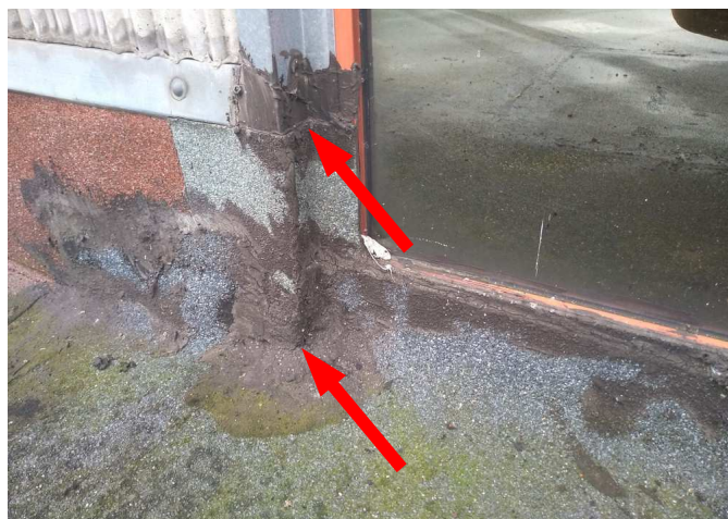
foto/42/ Pohled na ukončení hydroizolace na okenním rámu a pohled na opravování detailu
