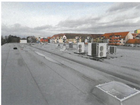
foto /10/ Severovýchodní pohled na řešenou střechu
