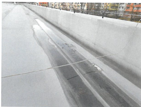
foto /35/ Vytažení fólie na konstrukci atiky a přetažení fólie přes vodorovnou plochu atiky s přesahem fólie na vnější stěnu atiky.
