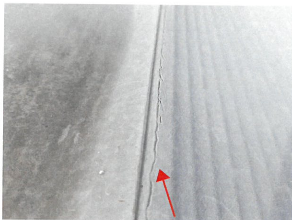
foto /28/ Tvorba trhlin v místě ohýbání fólie vlivem sání větru
