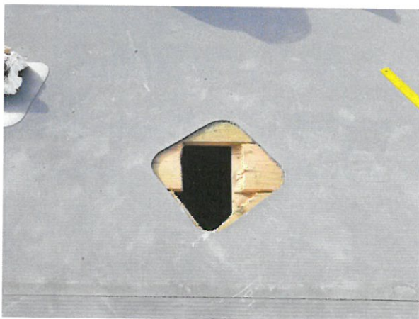
foto /6/ Pohled na provedenou sondu S2
