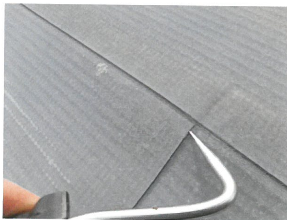
foto /29/ Zkouška kontrolní jehlou
