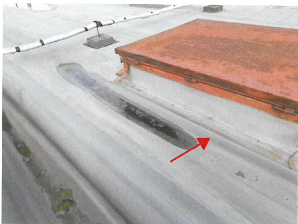
foto /32/ Vytažená fólie na výlezovém otvoru střechy.
