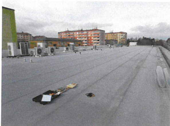
foto /2/ Pohled na umístění sondy S1 na předmětné střeše
