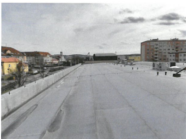
foto /12/ Severovýchodní pohled na řešenou střechu v místě nad přístavkem postaveném na terase řešené budovy
