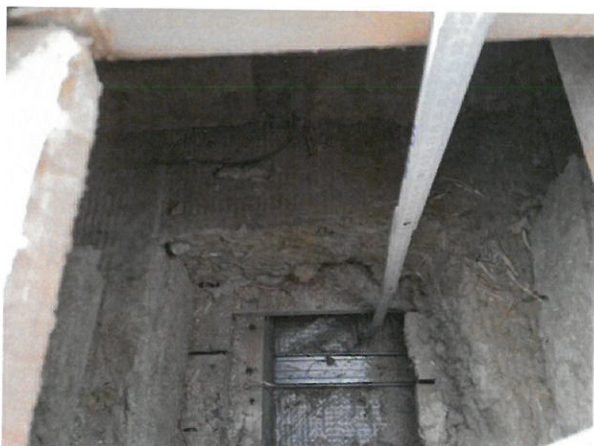
foto /4/ Pohled do sondy S1
