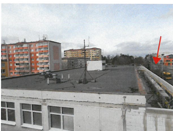
foto /13/ Pohled na sousední téměř identickou administrativní budovu, kde je stále původní skladba ploché střechy a v současné době probíhá obdobná výstavba přístavku na severovýchodní terase objektu (na přístavbu ukazuje šipka).
