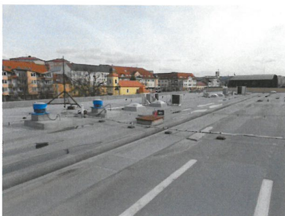
foto /11/ Jihovýchodní pohled na řešenou střechu
