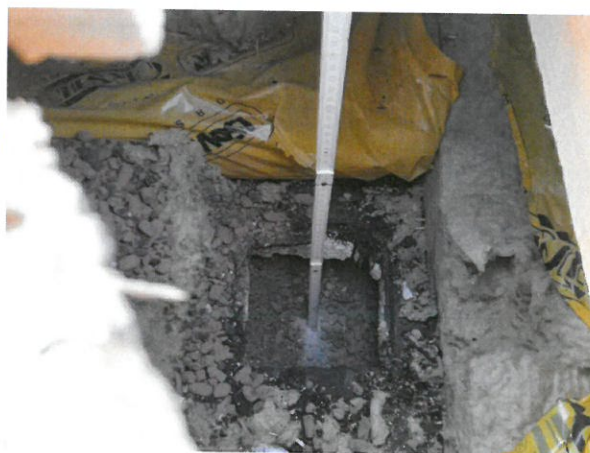
foto /7/ Pohled do sondy S2
