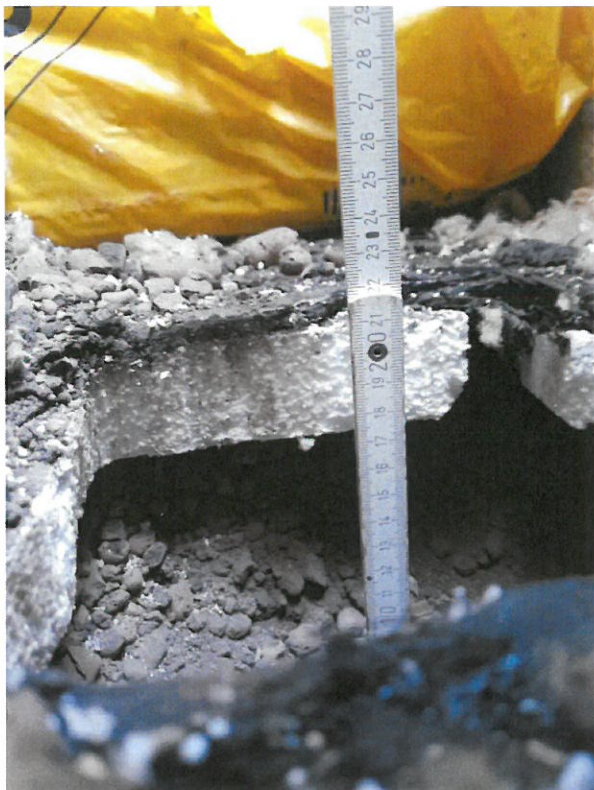
foto /8/ Detailní pohled do sondy S2 na skladbu původní ploché střechy s hlavní hydroizolační vrstvou ze souvrství asfaltových pásů
