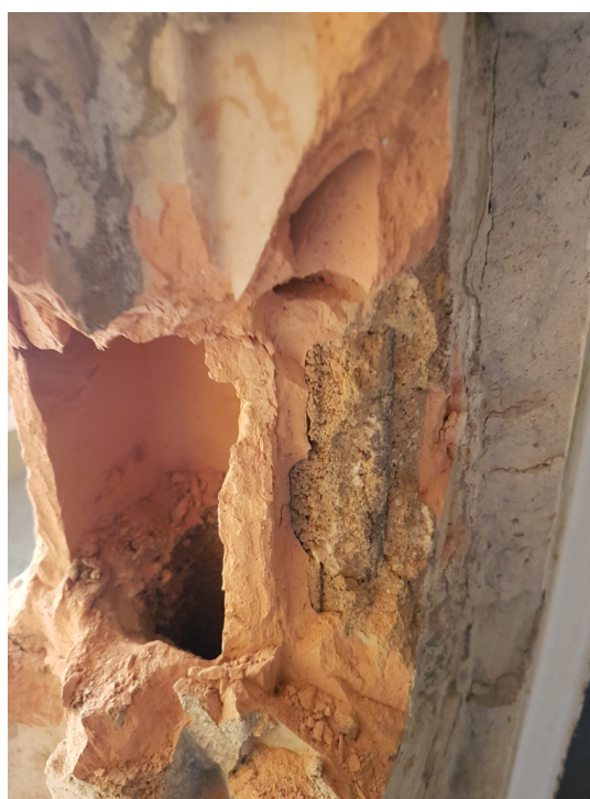
Obt.27 Detail osazení výztuže v tvarovce tvořící nosný sloupkový konstrukční systém vnějších i vnitřních nosných stěn.
