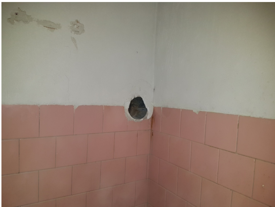
Obr.25 detail zaústění odvětrání od digestoře do prostoru koupelny. V uživatelské úpravě byl tento otvor ucpán. Digestoř byla užívána jako cirkulační bez odtahu nad střechu domu.
