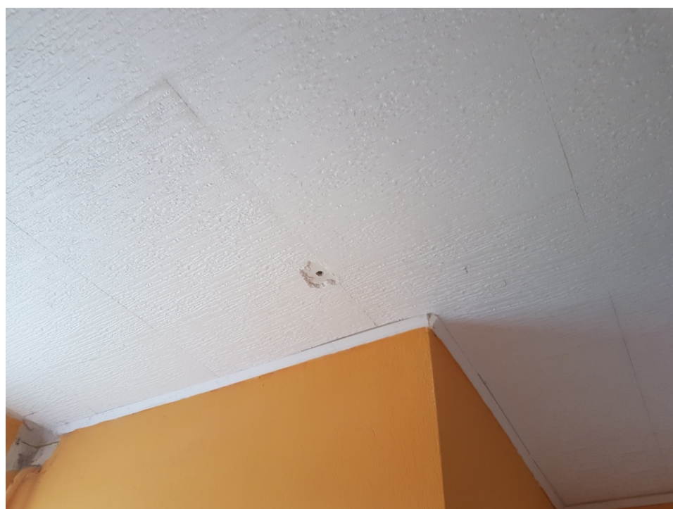
Obr.24 vrtaná sonda do stropního podhledu v prostoru obytné kuchyně.
