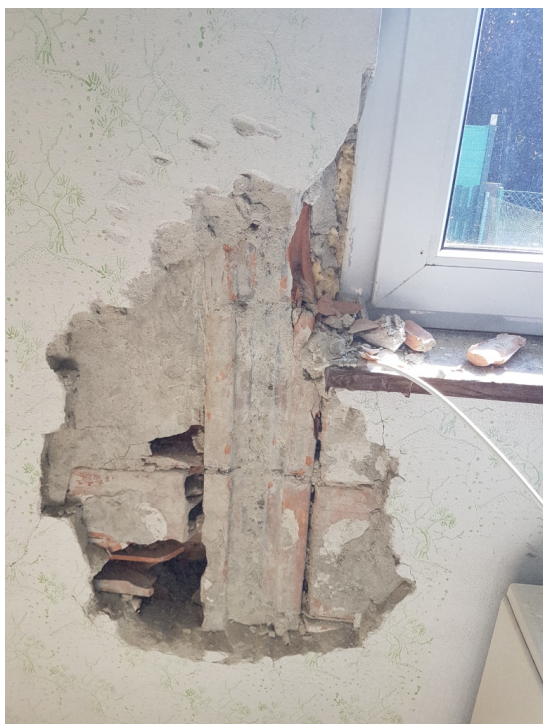
Obr.28 sonda do obvodové stěny. Viditelné desky hurdís kladeny na výšku desky do speciální kotvící tvarovky (patrná v obr.26) mezi deskami hurdís meze- ra vyplněná suti, případně nevyplněná.
