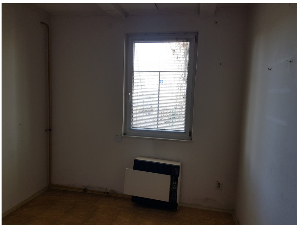
Obr.16 Pohled na plynové podpara-petní topidlo v prostoru obytné kuchyně s viditelným vlivem kondenzace ve styku podlaha obvodová stěna.
