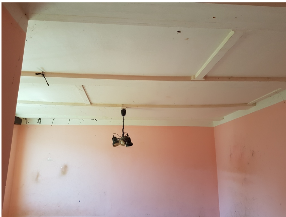
Obr.29 pohled na strop v BJ č.110 BD č.p.984. Vidi- telný průhyb strop- ní konstrukce – pásnice střešních sbíjených vazníků
