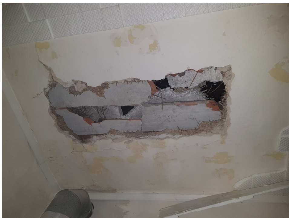
Obr.22 otevřená sonda do stropního podhledu v místě koupelny. Viditelný podhled, keramické desky, izolace lignopor a půdní prostor.
