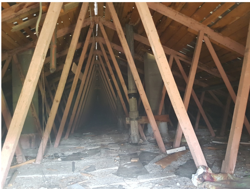
Obr.19 Vaznicová soustava konstrukce krovu s provedenou „izolací“ podlahy půdy. Patrné větrací potrubí koupelen a vedení komínových těles. Viditelné řešení pokládky střešní krytiny.
