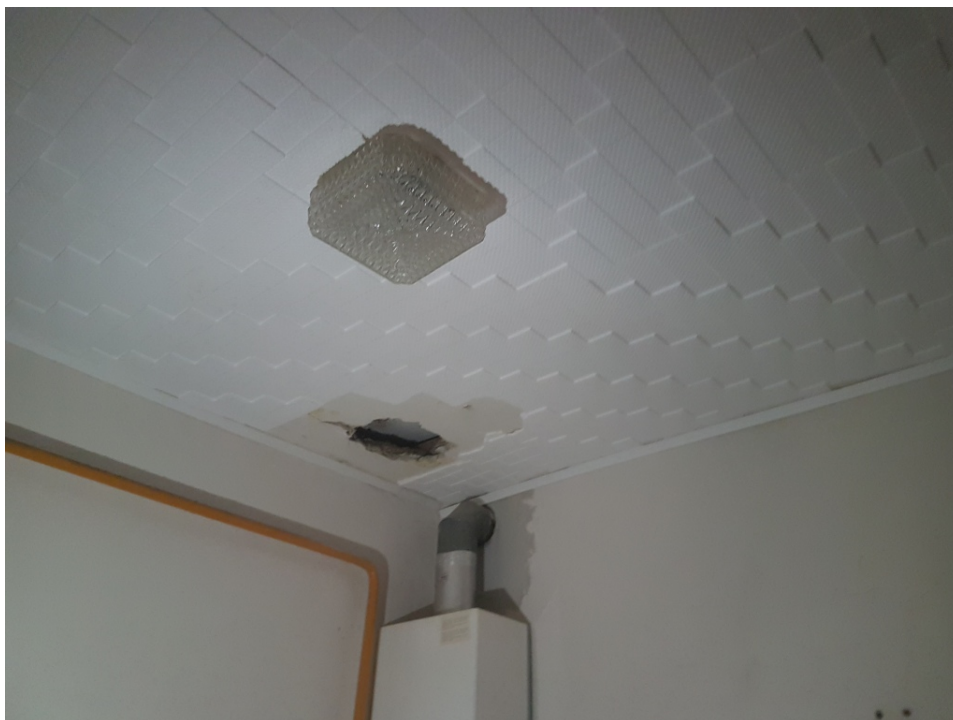
Obr.21 Pohled na strop koupelny v místě karmy s otevřenou sondou do podhledu. Viditelně strop bez větracích otvorů.
