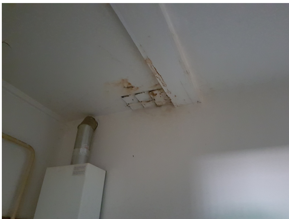
Obr.31 BJ č.104 BD 981 – detail větracího otvoru koupelny – viditelné zatečení kondenzace par.
