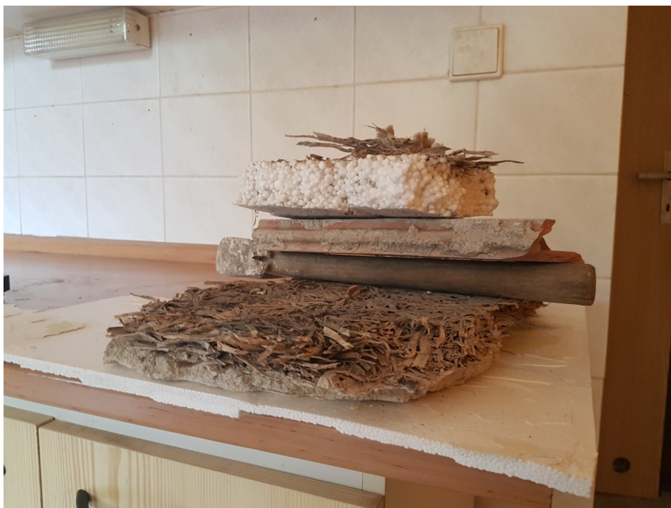
Obr.23 rekonstrukce skladby podhledu. – polystyrenová stropní kazeta lepená na omítku, VPC omítka na heraklitové desce, rošt pro kotvení heraklitových desek, keramická deska tl. cca 25mm, polystyrén/lignopor.
