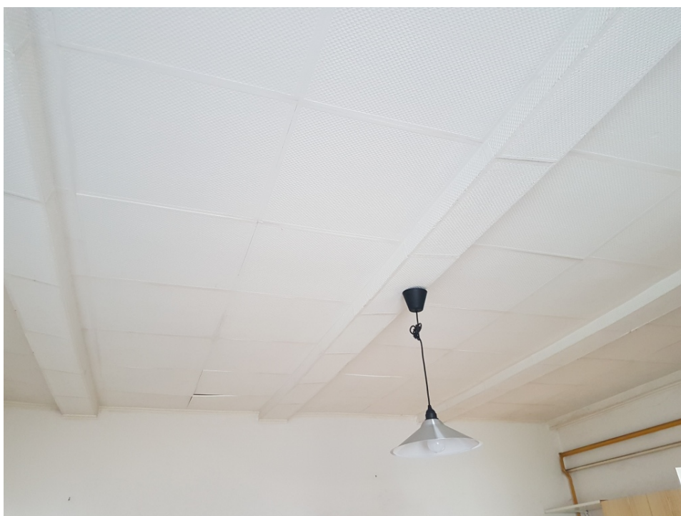
Obr.20 Pohled na stropní podhled v prostoru obytné kuchyně. Přes provedený nalepený podhled z kazet z EPS tl.5mm je viditelný průhyb střešních vazníků, které tvoří nosnou konstrukci pro podhled z cihelných půdovek
