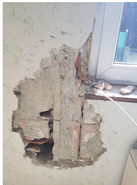
Obr.3 Cihelný sloupek obvodového zdiva
