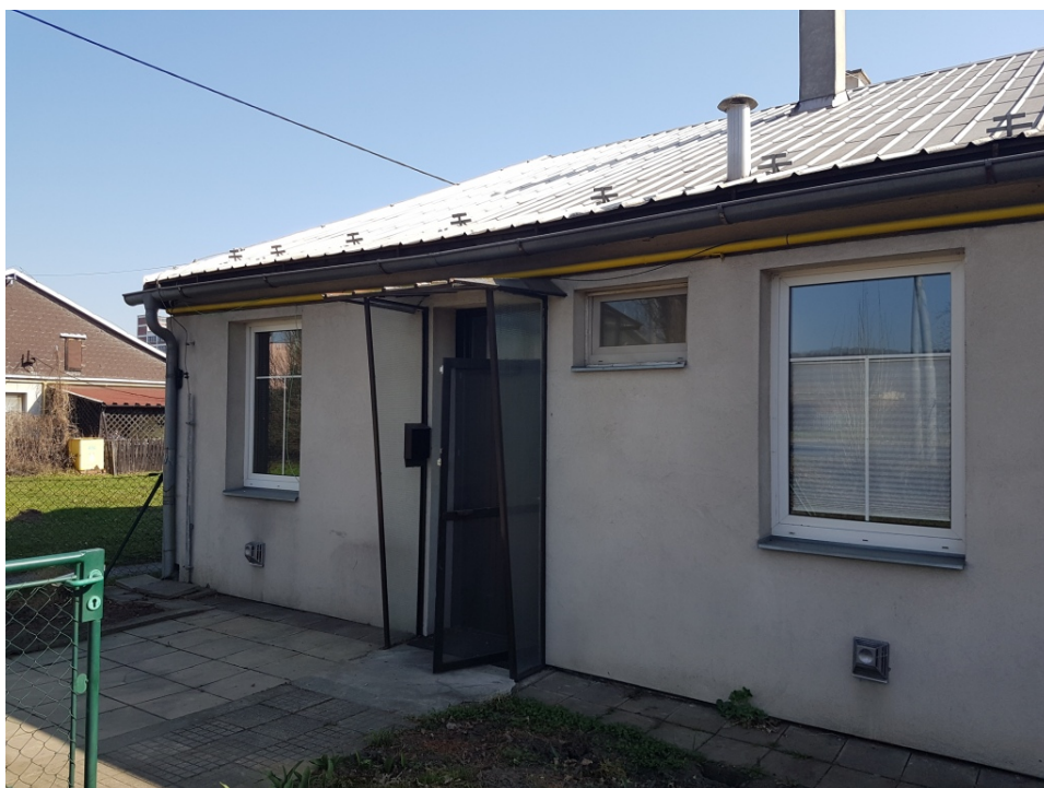
Obr.6 Pohled na vstup do bytové jednotky, západní fasáda, s viditelným odkouřením podparapetních plynových topidel.
