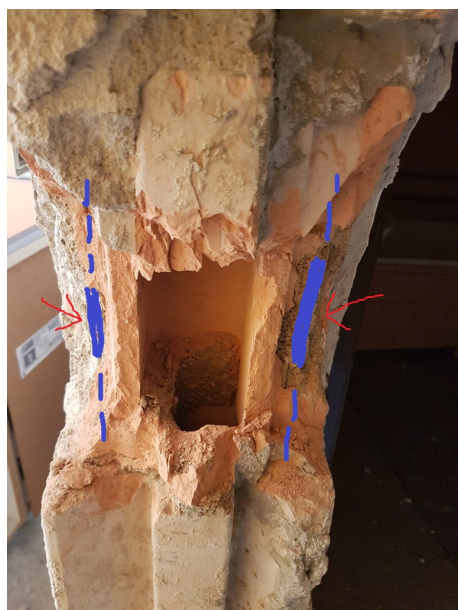
Obr.4 Detail vyztužení stěnového sloupku
