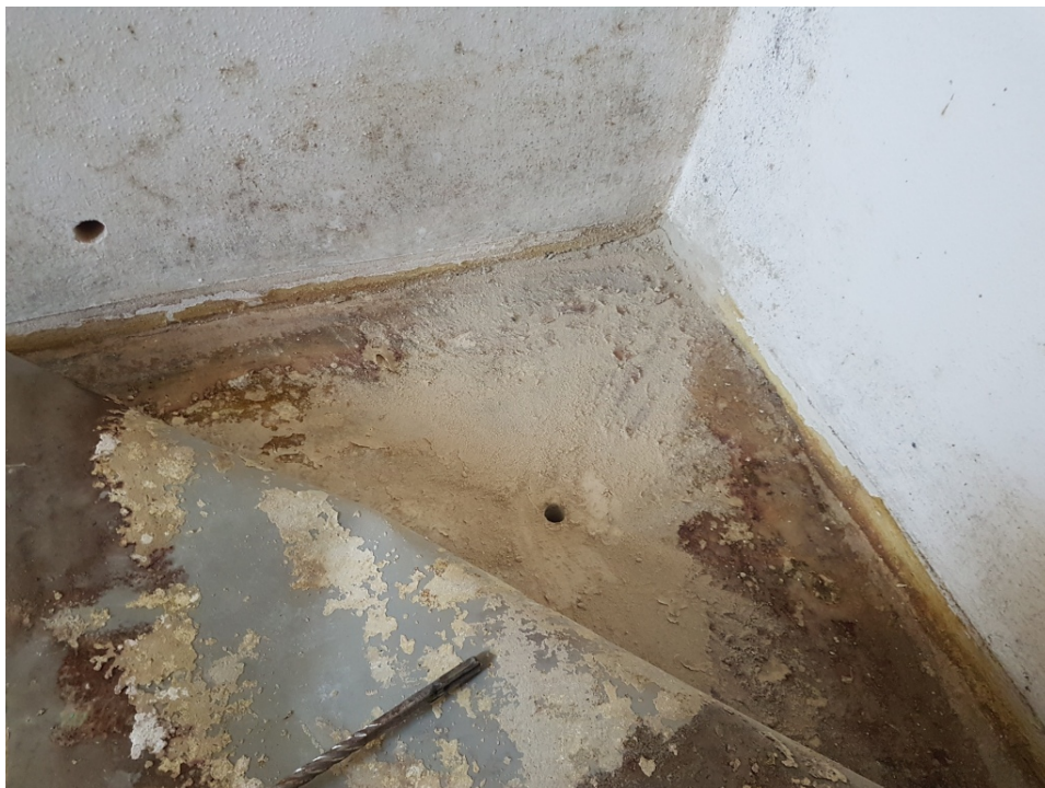
Obr.7 Vrtané sondy do podlahy a obvodové stěny v prostoru obytne kuchyně.
