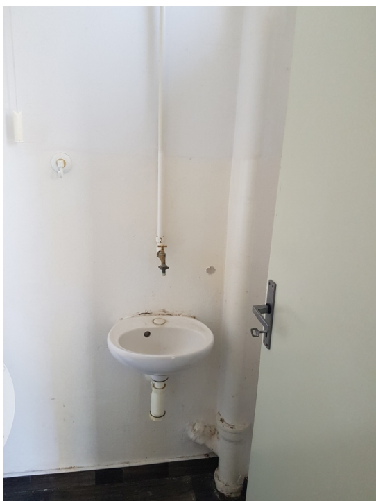
Obr.18 Přívod vody k umyvadlu na WC. Viditelné odvětrávací potrubí splaškové kanalizace.
