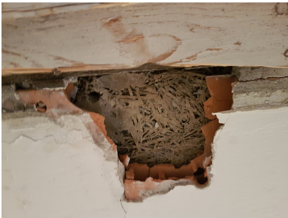
Obr.9 Detail sondy do stropního podhledu. Viditelná cihelná půdovka, a izolace heraklit.
