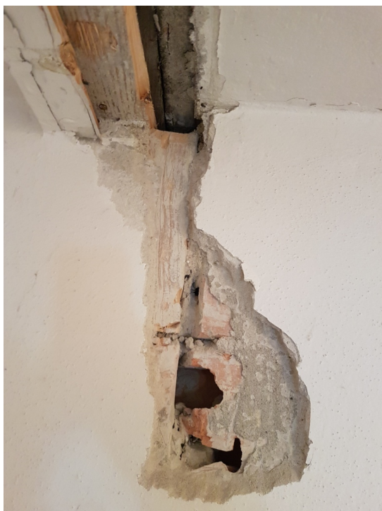
Obr.10 detail sondy oddělovací mezibytové příčky v koupelně referenční bytové jednotky. Příčka kolmá na osu střešního vazníku.
