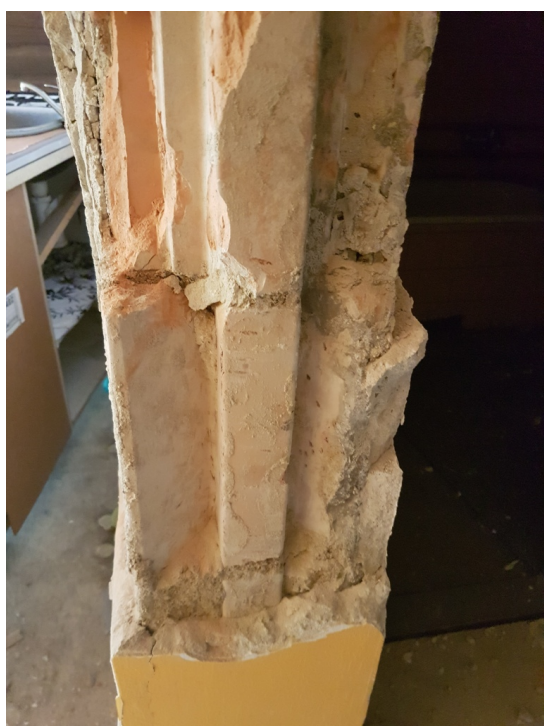
Obr.26 detail ostění příčky Z kuchyně směrem do koupelny. Viditelná cihelná tvarovka sloužící Jako kotvicí prvek pro desky hurdis
