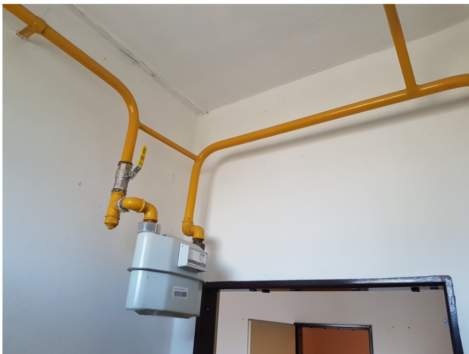
Obr.17 Bytový plynoměr ve vstupní chodbě.
