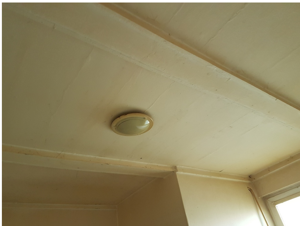
Obr.30 strop v BJ č. 104 BD č.p.981 - viditelné prolisování keramických desek podhledu.
